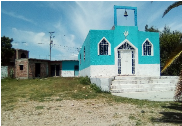
Imagen 16. Iglesia católica. Fuente: Propia (2018).
