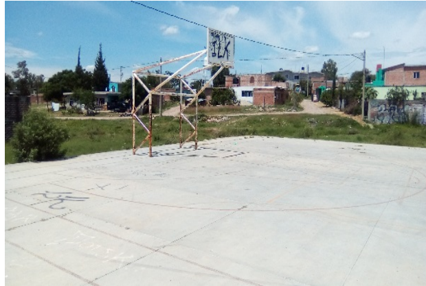
Imagen 18. Cancha de usos múltiples Fuente: Propia (2018).
