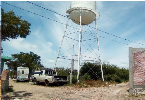
Imagen 4. Tanque metálico elevado. Fuente: Propia (2018).
