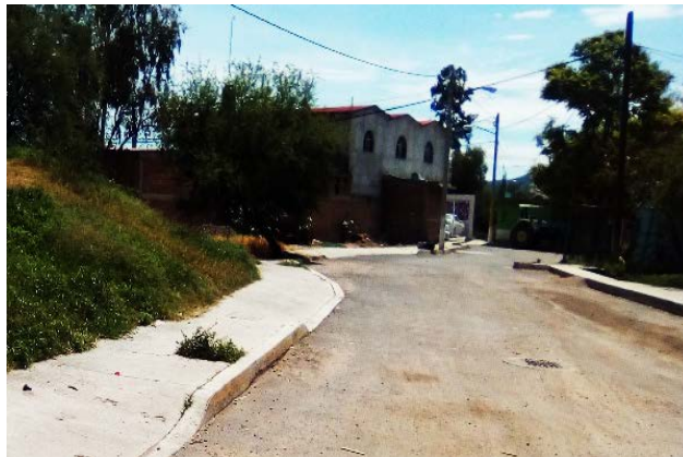
Imagen 9. Línea de energía eléctrica y telefonía en calle Rosas. Fuente: Propia (2018).
