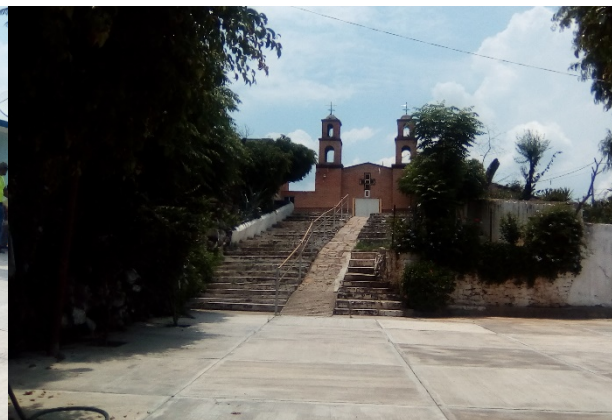
Imagen 10. Iglesia católica. Fuente: Propia (2018)
