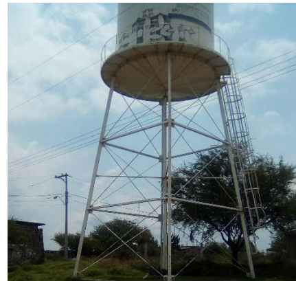
Imagen 2. Tanque metálico elevado. Fuente: Propia (2018).
