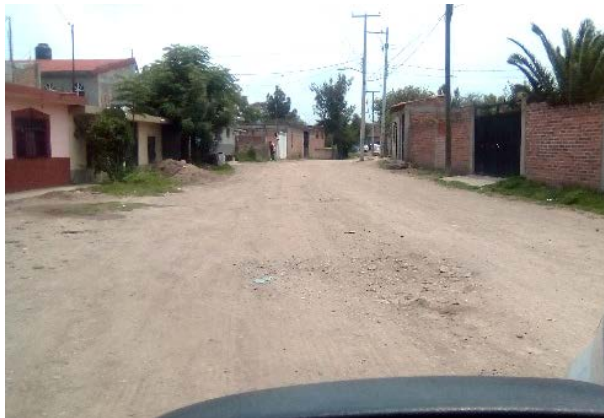
Imagen 3. Línea de energía eléctrica y telefonía en calle Santos Degollado. Fuente: Propia (2018).
