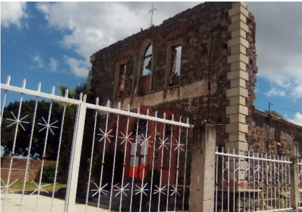
Imagen 12. Iglesia católica. Fuente: Propia (2018).
