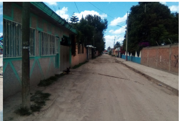
Imagen 5. Postes y red de energía eléctrica y telefonía sobre calle Real. Fuente: Propia (2018)
