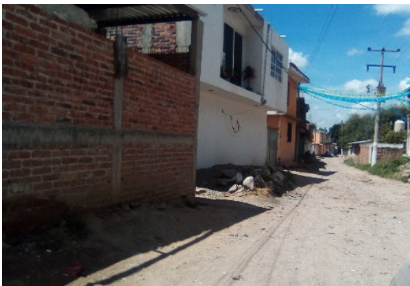
Imagen 4. Línea de Energía eléctrica. Fuente: Propia (2018).
