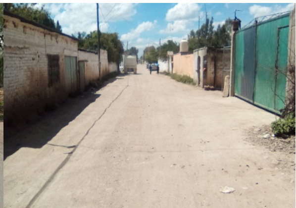
Imagen 9. Calle Real sin pavimentar. Fuente: Propia (2018).
