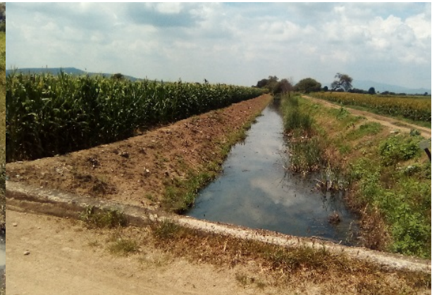
Imagen 4. Canal de riego donde descargan aguas residuales. Fuente: Propia (2018).
