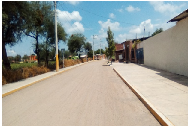
Imagen 7. Calle Insurgentes pavimento asfáltico. Fuente: Propia (2018).
