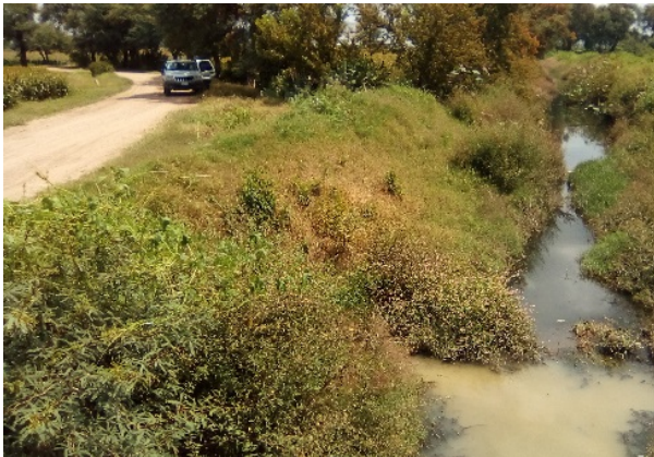
Imagen 3. Descarga a canal. Fuente: Propia (2018).
