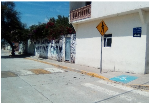
Imagen 11. Calle 5 de mayo con pavimento de concreto hidráulico. Fuente: Propia (2018).
