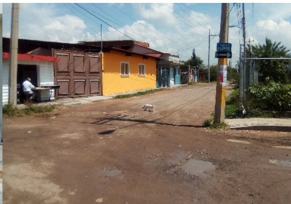
Imagen 12. Calle Ramón Corona esquina Allende sin pavimento. Fuente: Propia (2018).
