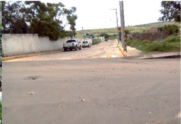
Imagen 5. Pozo de visita sobre calle pavimentada. Fuente: Propia (2018).
