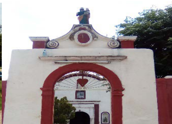
Imagen 15. Iglesia cristiana. Fuente: Propia (2018)
