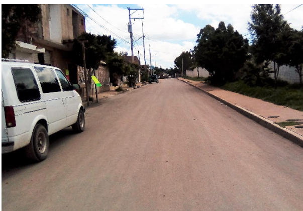
Imagen 10. Calle Benito Juárez pavimento asfáltico. Fuente: Propia (2018).
