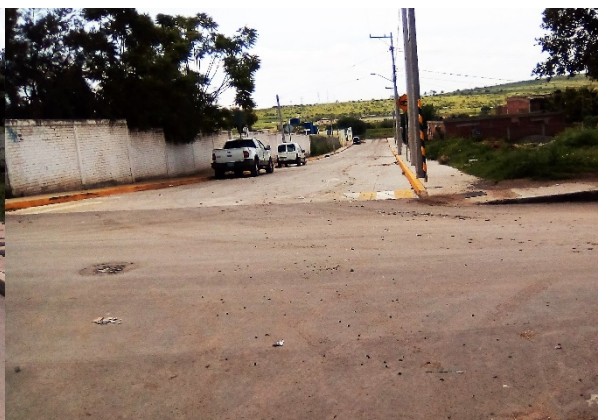
Imagen 11. Calle Central pavimento concreto hidráulico. Fuente: Propia (2018).
