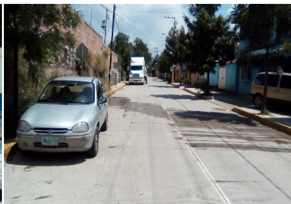
Imagen 7. Calle Morelos con pavimento de concreto en la localidad. Fuente: Propia (2018).
