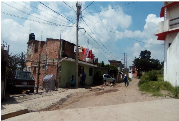
Imagen 3. Intersección con la calle Morelos, se observa red de energía eléctrica y alumbrado público con que cuenta la localidad. Fuente: Propia (2018).
