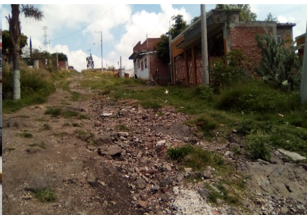
Imagen 11. Entrada de la calle Veracruz, carece de banquetas y guarniciones. Fuente: Propia (2018).
