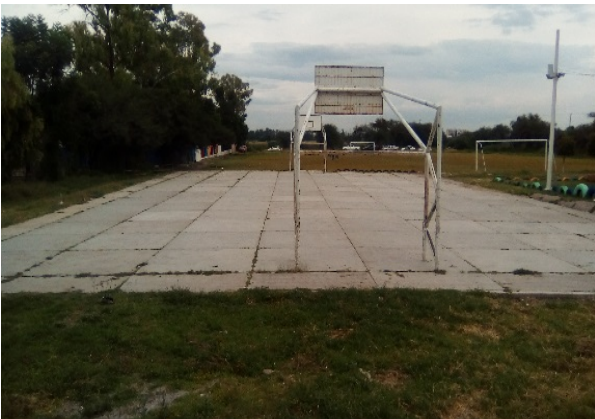
Imagen 16. Cancha de usos múltiples. Fuente: Propia (2018).
