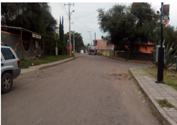
Imagen 5. Línea de Luz y telefonía en calle Copal. Fuente: Propia (2018).
