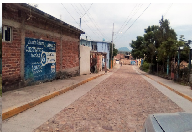
Imagen 6. Línea de luz y telefonía sobre calle Casuarina. Fuente: Propia (2018).
