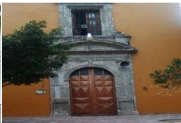
Imagen 13. Iglesia católica. Fuente: Propia (2018)
