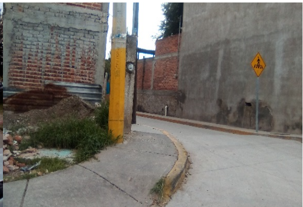
Imagen 8. Calle Opuntia pavimento concreto hidráulico. Fuente: Propia (2018).
