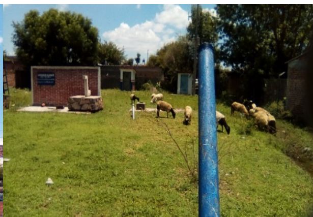
Imagen 4. Tren de válvulas del pozo profundo ubicado en la Calle 5 de mayo. Este pozo suministra de agua a toda la localidad. Fuente: Propia (2018).
