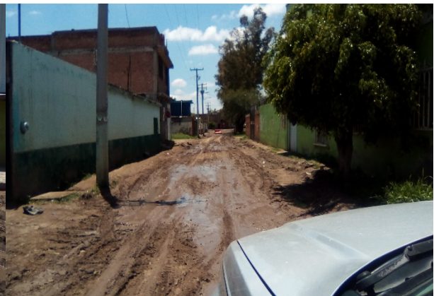
Imagen 15. Calle 5 de mayo vialidad sin pavimentar. Fuente: Propia (2018).
