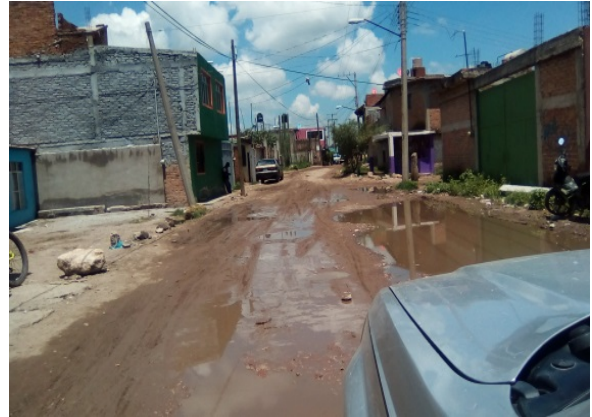
Imagen 10. Calle Benito, cuenta con servicio de energía eléctrica y alumbrado público como la mayoría de las calles. Fuente: Propia (2018).
