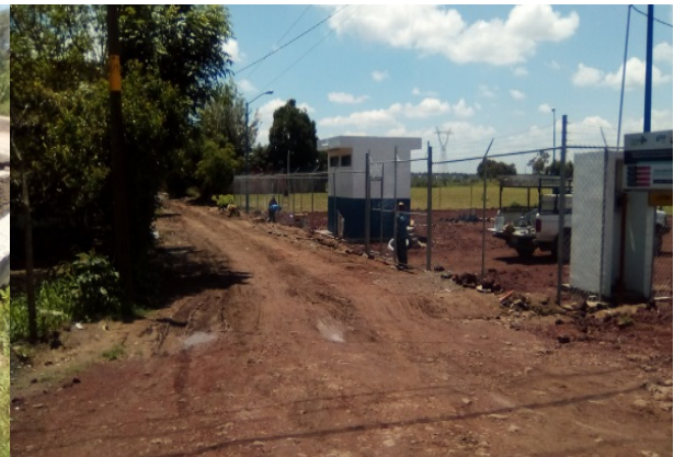
Imagen 6. Planta de Tratamiento de Aguas Residuales, actualmente en construcción. Fuente: Propia (2018).
