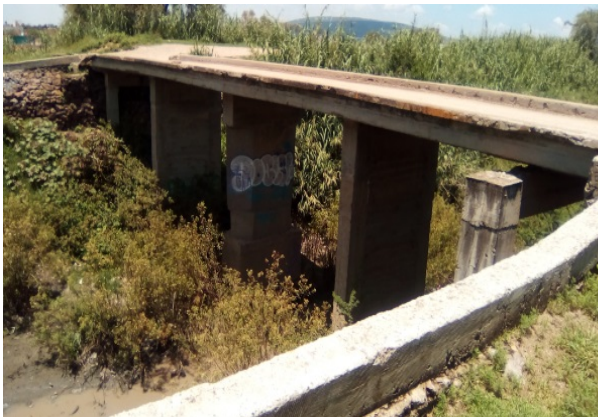
Imagen 5. Puente Vehicular sobre el Rio Guanajuato Fuente: Propia (2018).
