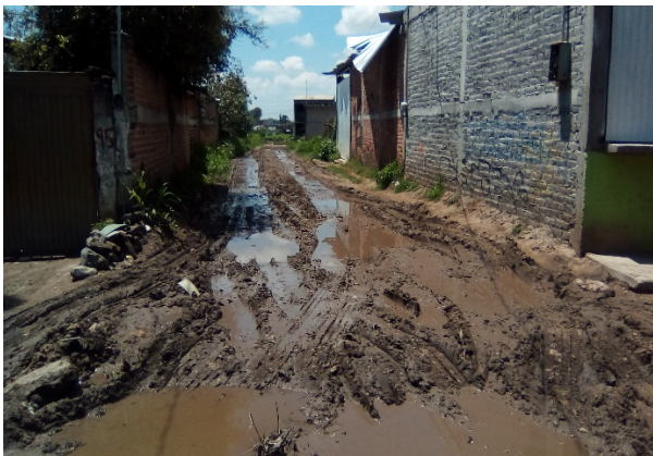
Imagen 14. Calle Benito Juárez vialidad sin pavimentar. Fuente: Propia (2018).
