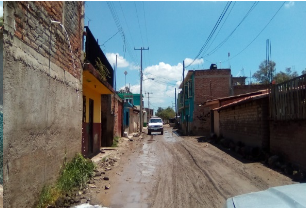
Imagen 8. Falta de la red drenaje sanitario y pluvial en la calle Morelos. Fuente: Propia (2018).
