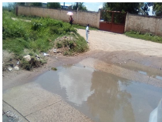
Imagen 4. Agua por tubería tapada. Fuente: Propia (2018).
