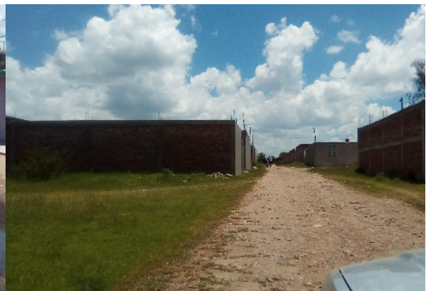
Imagen 14. Acceso de terracería a la UMAPS en construcción. Fuente: Propia (2018).
