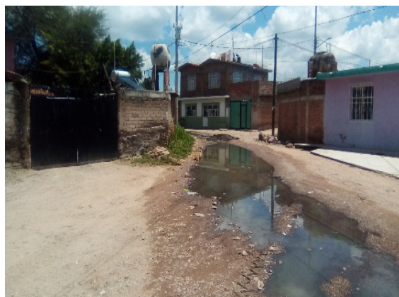
Imagen 5. Escurrimientos por drenaje tapado. Fuente: Propia (2018).
