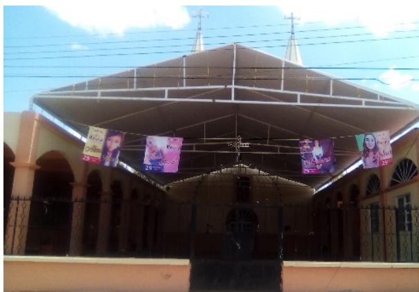
Imagen 19. Frente Iglesia, Fuente: Propia (2018)
