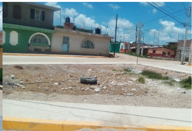
Imagen 7. Red de energía eléctrica alumbrado z y telefonía entrecruzados. Fuente: Propia (2018)
