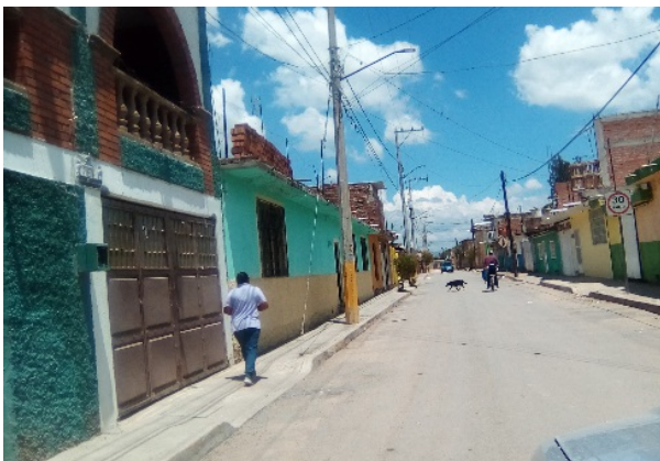
Imagen 6. Red de energía eléctrica alumbrado y telefonía. Fuente: Propia (2018).
