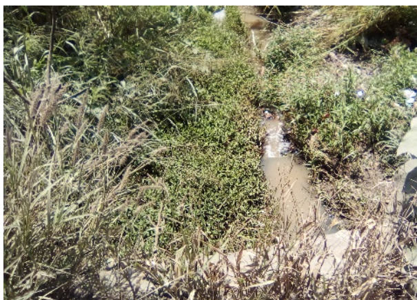
Imagen 3. Descarga de drenaje. Fuente: Propia (2018).
