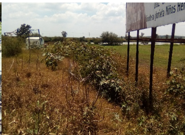
Imagen 4. Descarga de drenaje hacia zona inundable. Fuente: Propia (2018).
