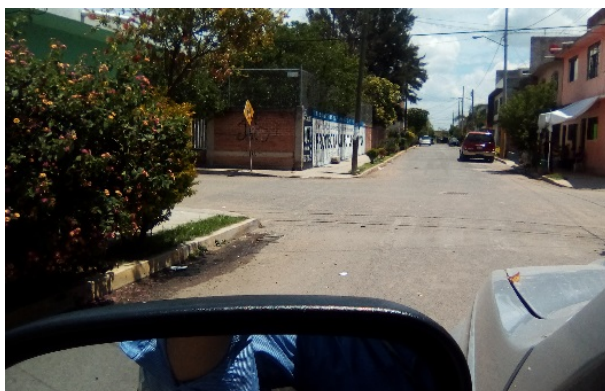
Imagen 5. Drenaje en calle pavimentada. Fuente: Propia (2018).
