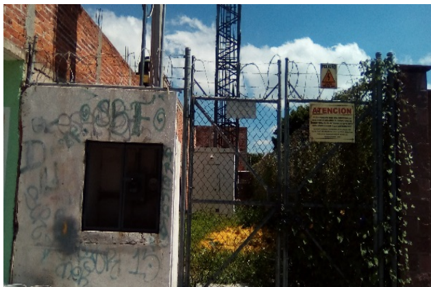
Imagen 8. Antena de Telecomunicaciones. Fuente: Propia (2018)
